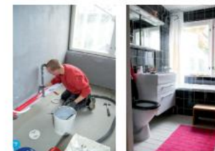
Vedeneristysvaihe ja uusittu kylpyhuone.
